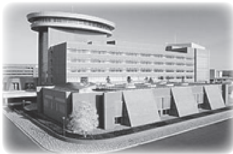
日本大学 工学部70号館
